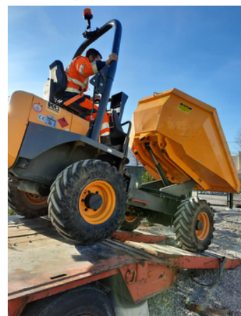
Déchargement mini dumper
