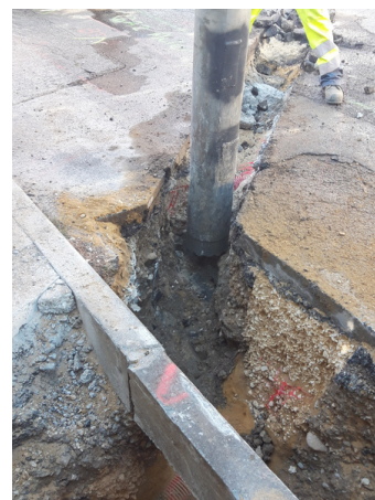
Mise en situation
