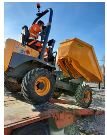
Déchargement mini dumper
